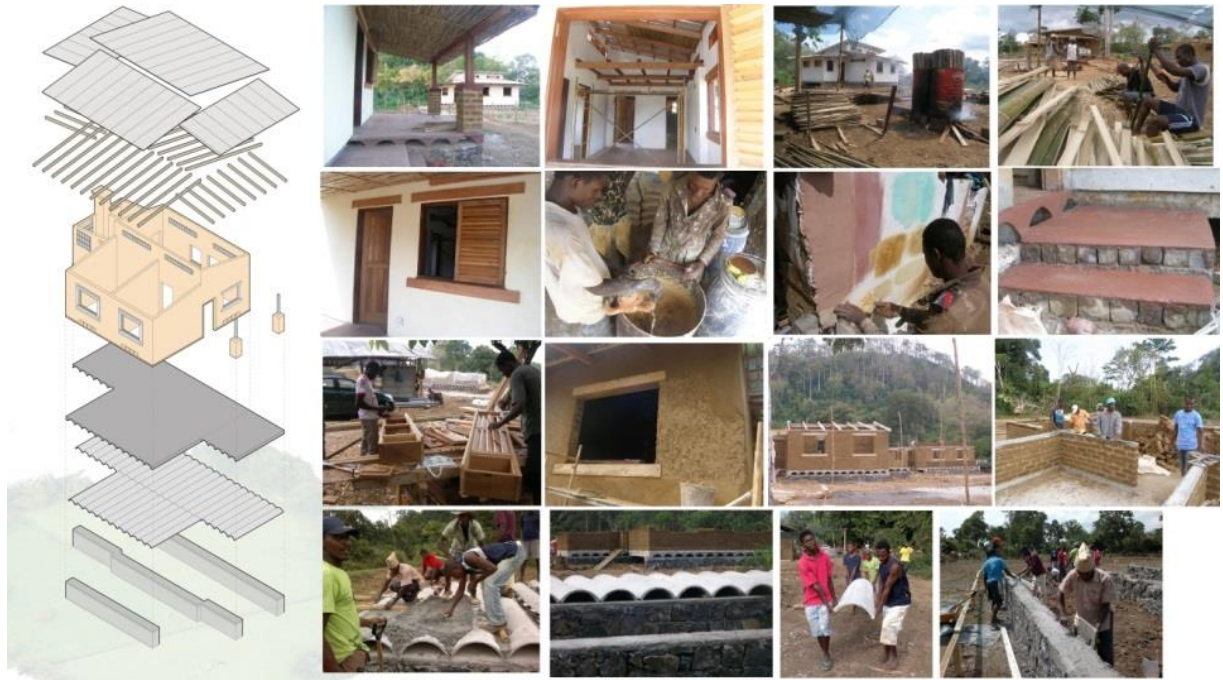
Figura 4 – Maquete explodida e fotos das tecnologias construtivas.
